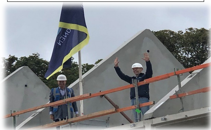
Nieuwbouw 40 duurzame eengezinswoningen Kingsford Smitstraat Beverwijk
